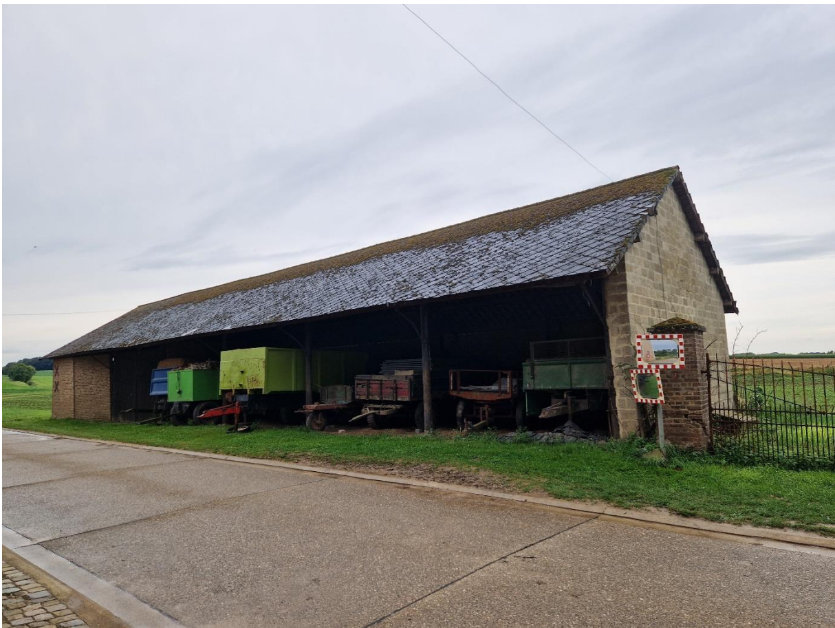
Fig. 70: De vleugel rechtover de hoeve werd pas in de loop van de 20 ste eeuw gebouwd. De langwerpige volumetrie onder zadeldak sluit goed aan bij de vierkantshoeve.
