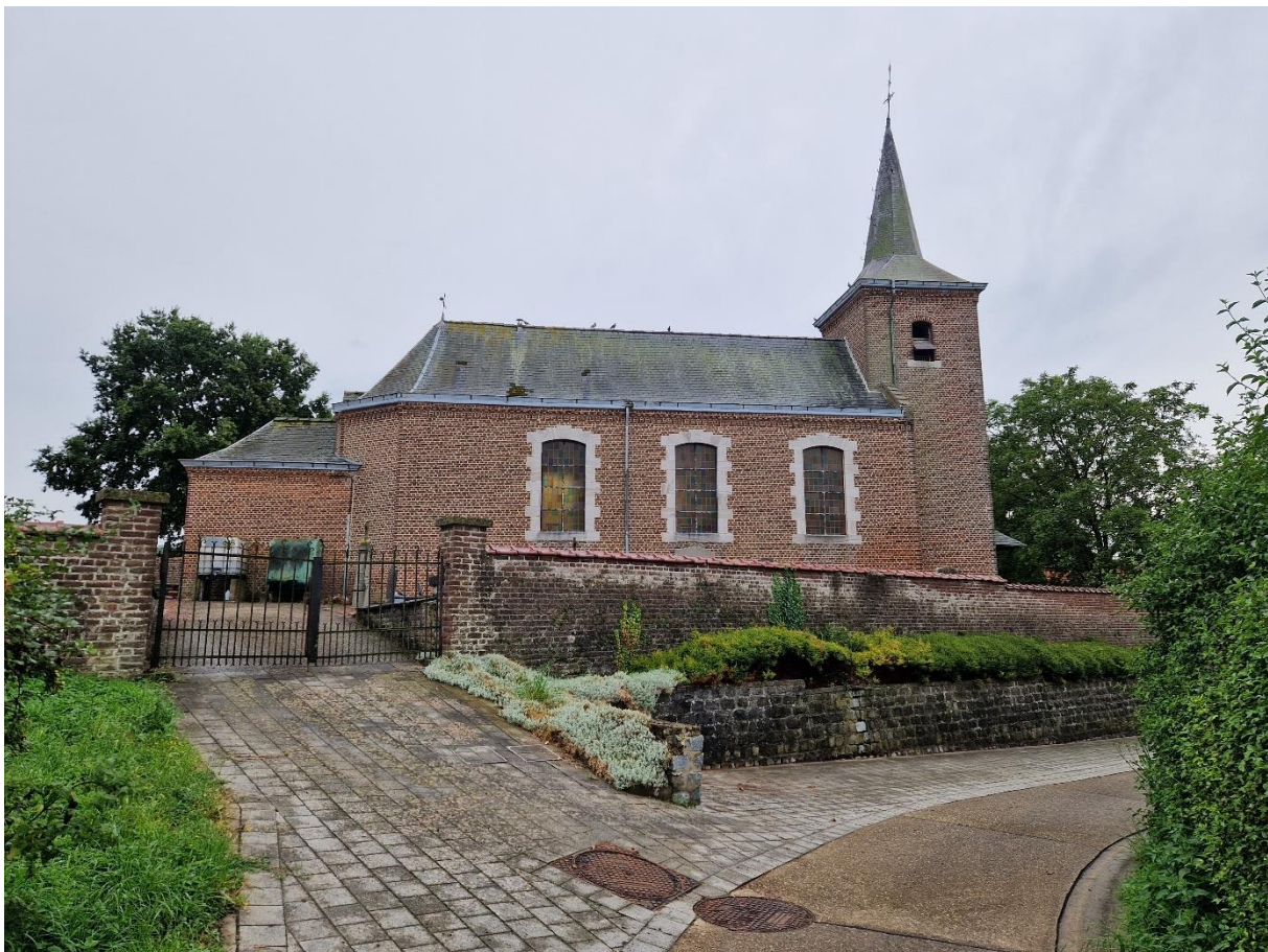
Fig. 58: Overzicht van de kerk met kerkhofmuur.
