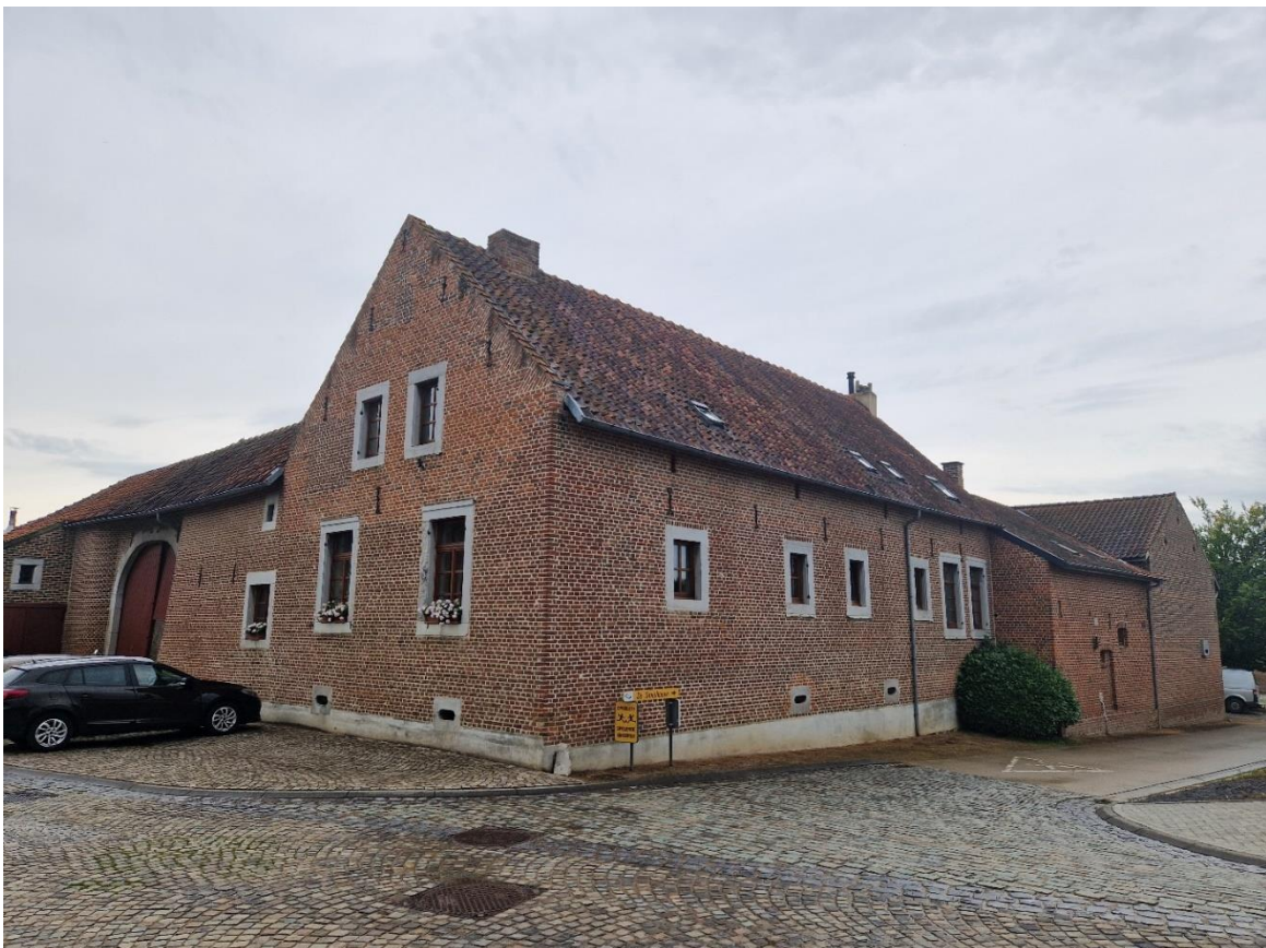
Fig. 116: Overzicht van de vierkantshoeve.
