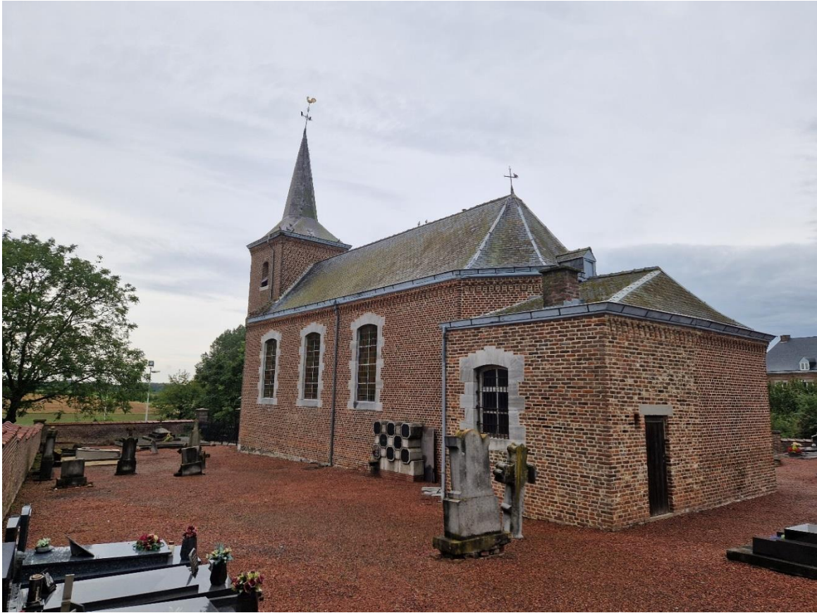
Fig. 59: Overzicht van de koorzijde van de kerk, met sacristie.
