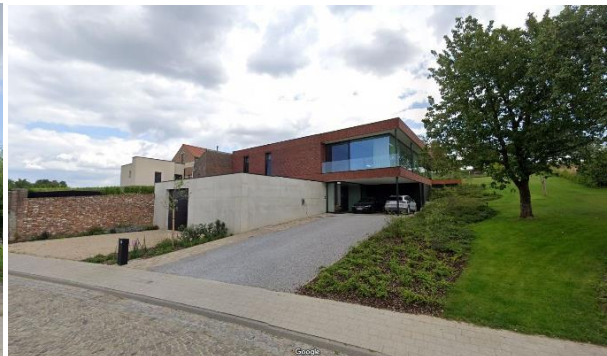
Fig. 155: Batsheersstraat 34: nieuwbouw 2 bouwlagen plat dak, ingewerkt in maaiveld.
