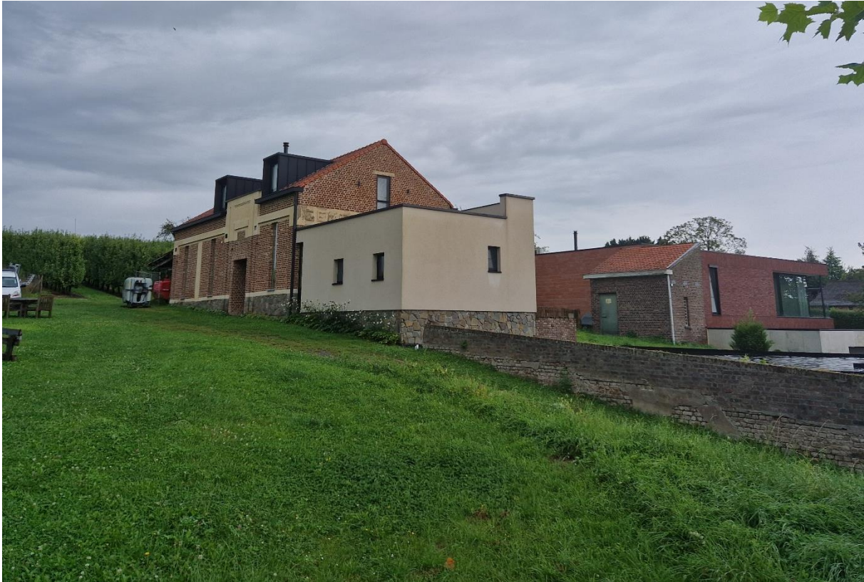
Fig. 121: Overzicht van de heden tot woning herbestemde school.
