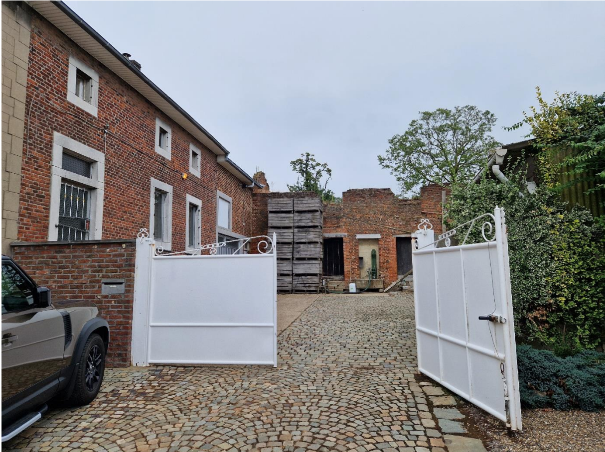
Fig. 38: Hedendaagse toestand van het erf. Er werd in de loop van de 20 ste eeuw een ommuring met poort toegevoegd. Rechts de uitloper van de hangar die toegevoegd werd op de voormalige open buitenruimte. De grond werd enerzijds deels gebetonneerd, maar anderzijds grotendeels afgewerkt met kleine kasseitjes.
