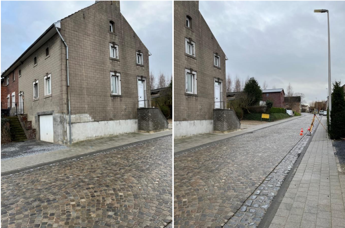
Fig. 138: Overzicht van de straatzijde, ten noorden van de hoeve.
