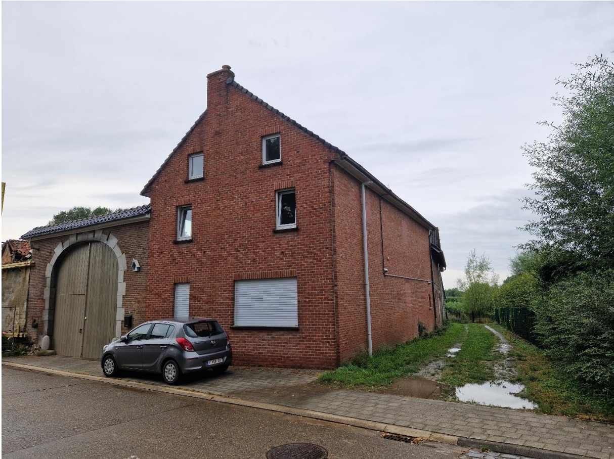
Fig. 92: Op een hedendaagse foto is te zien dat de hoeve nog de oude contouren volgt, maar dat het volume heropgebouwd is geweest, met behoud van de historische poortopening. Rechts ervan werd in de loop van de 20 ste eeuw een klein volume bijgebouwd, zoals nog op de luchtfoto te zien, maar dit werd recent gesloopt.
