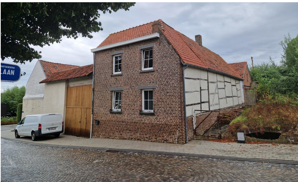
Fig. 135: Overzicht van de hoeve langs de Kapelstraat. In de zijgevel is het vakwerk nog duidelijk zichtbaar.
