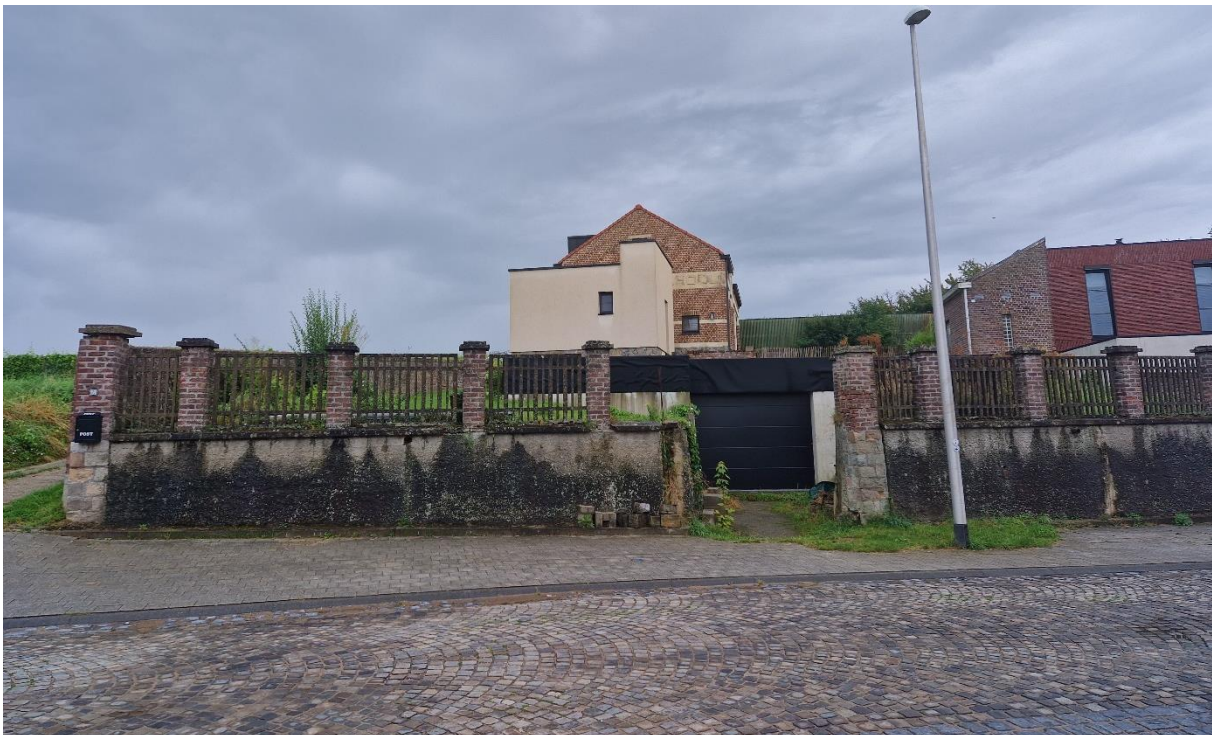
Fig. 122: De originele interbellumomheining bleef bewaard en verbergt een garagevolume dat bij de herbestemming werd toegevoegd. Op de achtergrond ook een nieuw toegevoegde lage lange smalle vleugel, in neutrale vormgeving en bekleed met hout.
