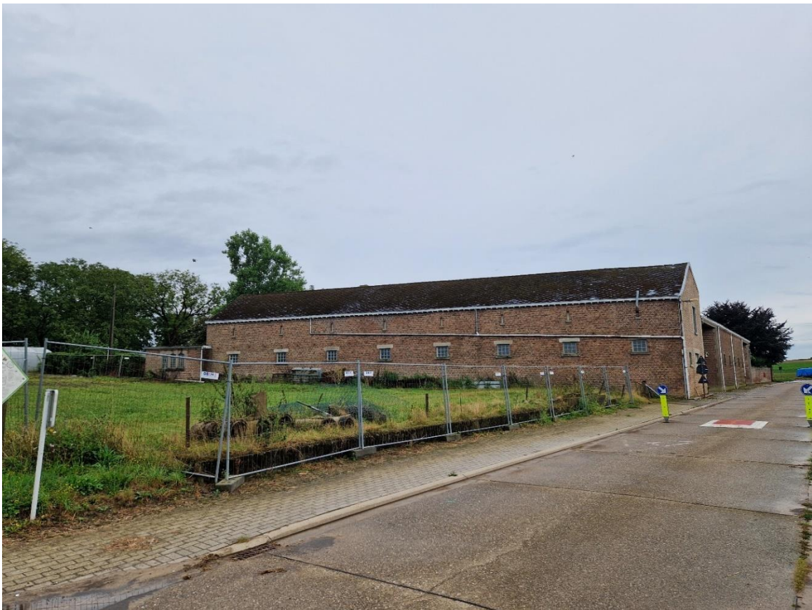
Fig. 69: Overzicht van de vierkantshoeve.
