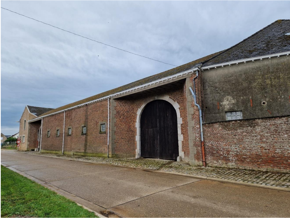
Fig. 68: Overzicht van de vierkantshoeve.
