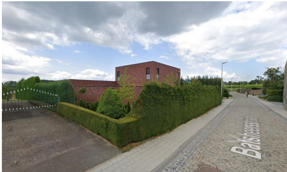
Batsheersstraat 31: nieuwbouw 2 bouwlagen plat dak
