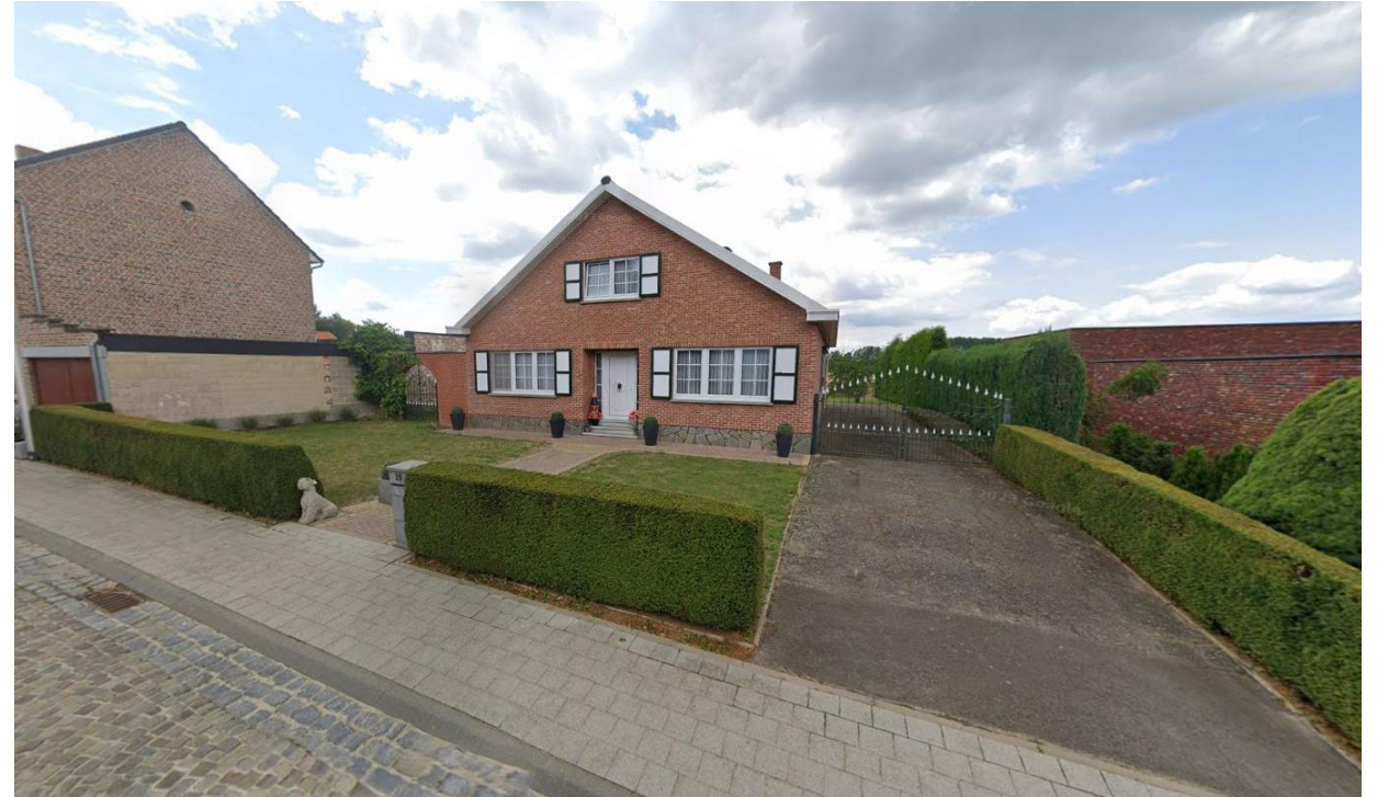
Batsheersstraat 29: 1 bouwlaag hellend dak
