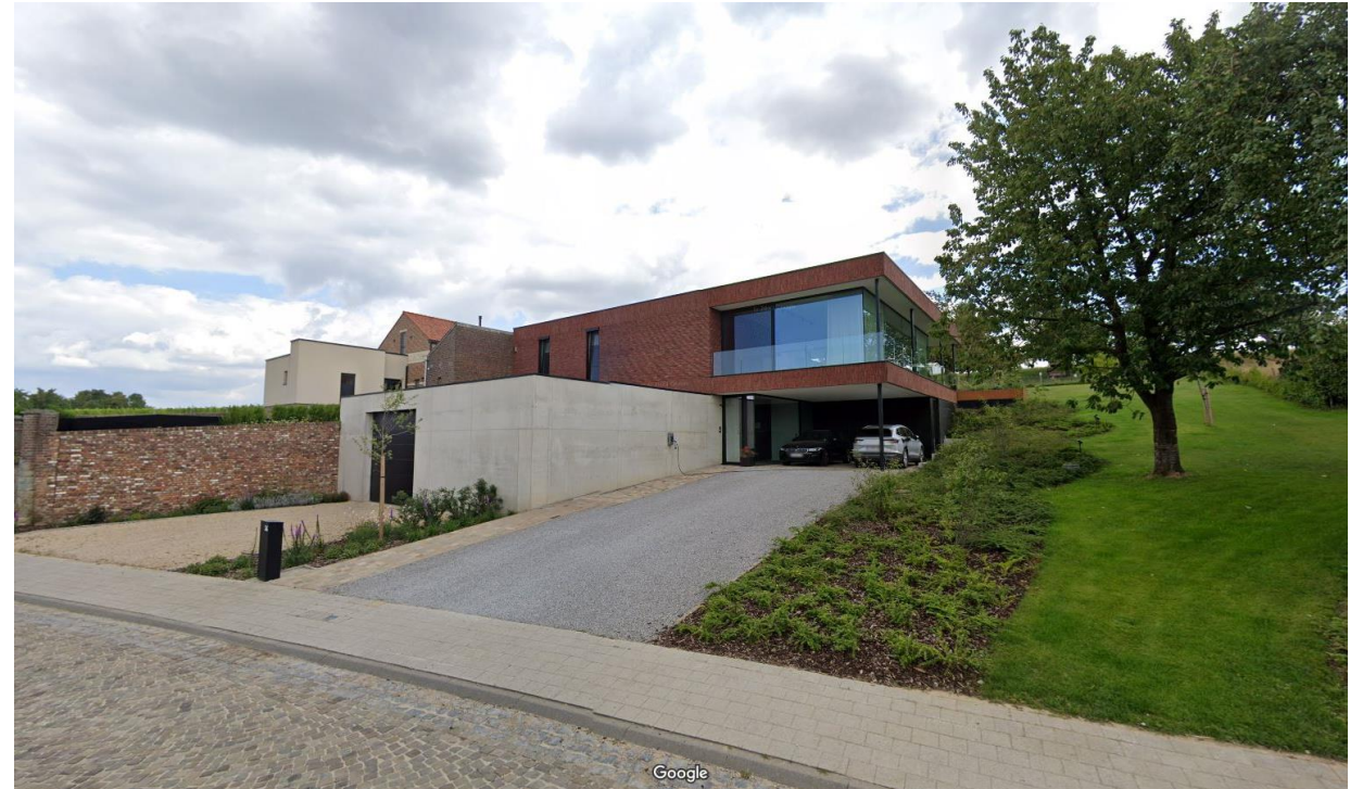
Batsheersstraat 34: nieuwbouw 2 bouwlagen plat dak, ingewerkt in maaiveld
