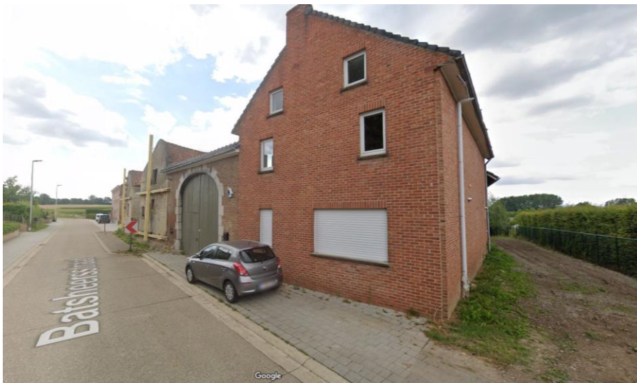
Batsheersstraat 17-19: hoeves 1,5 tot 2 bouwlagen met hellend dak
