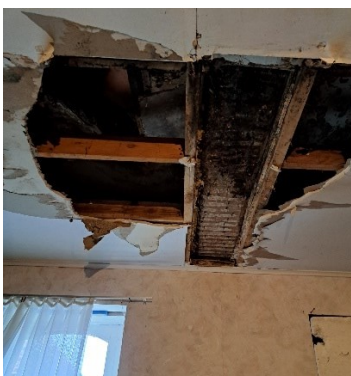
zicht op de plafondafwerking van de verdiepingsvloer
