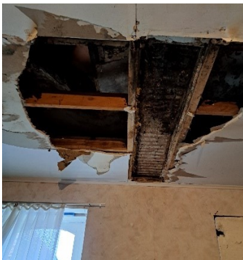
zicht op de plafondafwerking van de verdiepingsvloer
